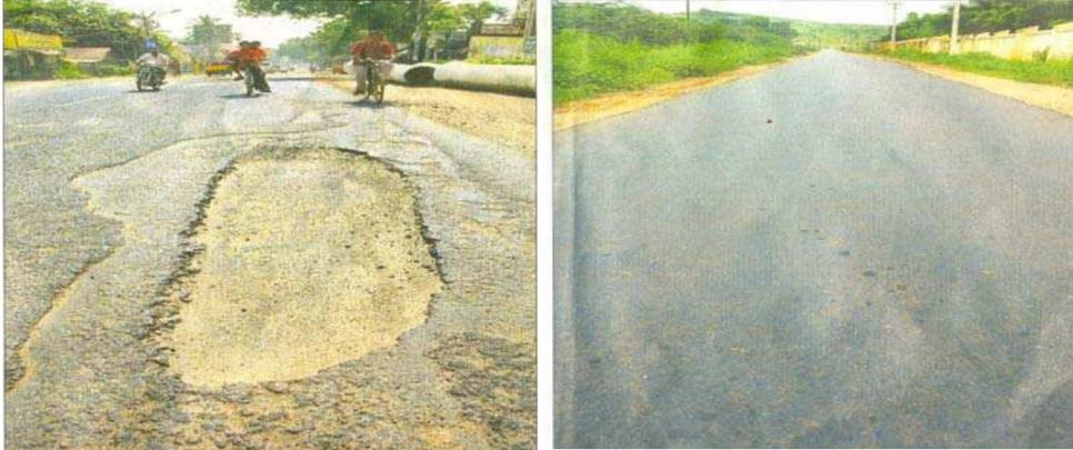
Figura 3. Comparación entre pavimento común y modificado de dos carreteras en India. Bale (2011).
