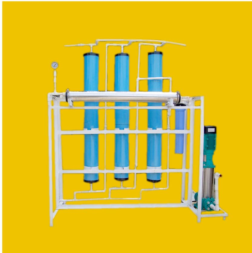
Figura 2. Batería de filtros de pretratamiento.
