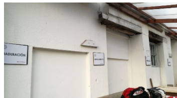
Figura No 1 (Adecuación Eco laboratorio) Fuente autores.
