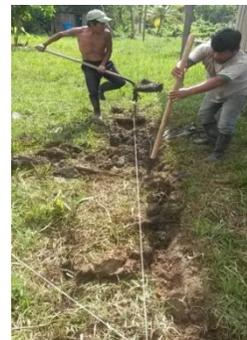
Figura 6 Excavación para la Cimentación
