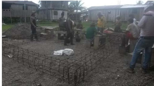
Figura 7 Figurado de refuerzo para las estructuras, zapatas y vigas de cimentación
