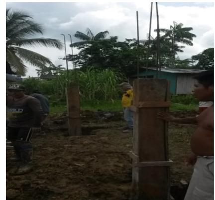
Figura 8 Mezcla para el vaciado de la cimentación y Preparación de estructura para la fundición de las zapatas y las vigas.
