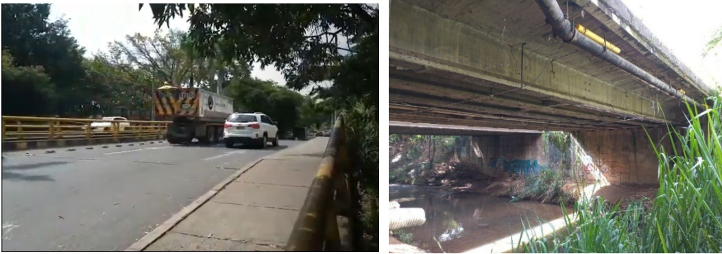
Figura 1. Puente en concreto preesforzado ubicado en la calle 16, Cali.
