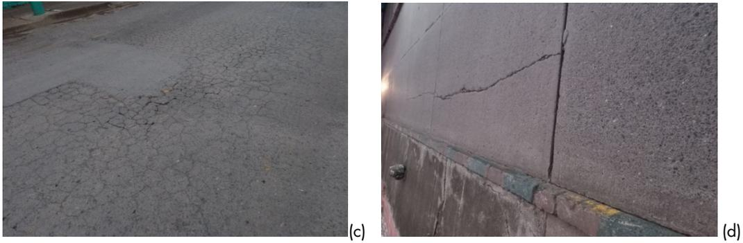
**Figura 6. Fallas identificadas (a) Fisura transversal (carera 10), (b) Bache y desprendimiento de agregados (Calle 15), (c) Parche y piel de cocodrilo (Calle 16), (d) Fisura longitudinal (Carrea 9a).**
