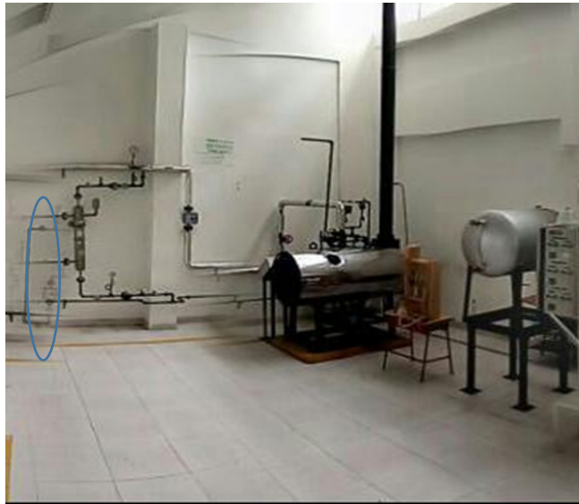
Imagen No 4. Intercambiador de coraza y tubos.
