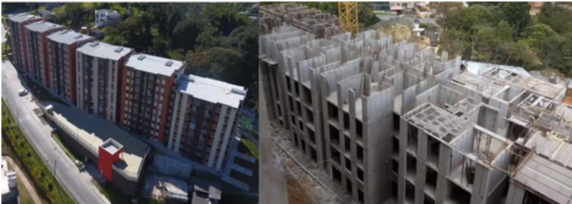
Fig. 1. a) Sistema estructural de muros de hormigón reforzado delgados. b) Formas típicas de los muros del sistema
