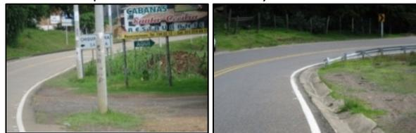
La señalización vertical no es coherente con la geometría y función de la vía, mal localizada, existen incoherencias, y está obstruida como se observa en la Figura 5.
