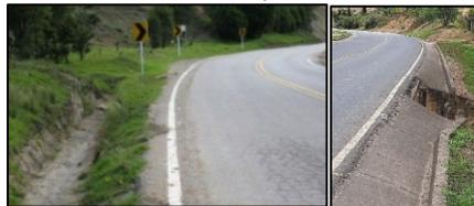
Sección transversal no acorde con la categoría de la vía, sin bermas, taludes no transitables y visibilidad afectada por la presencia de árboles como se observa en la Figura 3.
