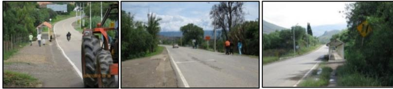
Cunetas no transitables, ancho escaso y pegadas a la calzada. Alcantarillas en curva, angostas, cabezotes sin protección y peligro de caída para los usuarios, como se observa en la Figura 2.
